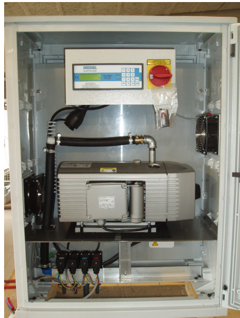
Innenansicht mit Steuerung, Verdichter DT 4.16 und Ventilanschlüssen
